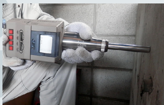
コンクリートの圧縮強度測定
